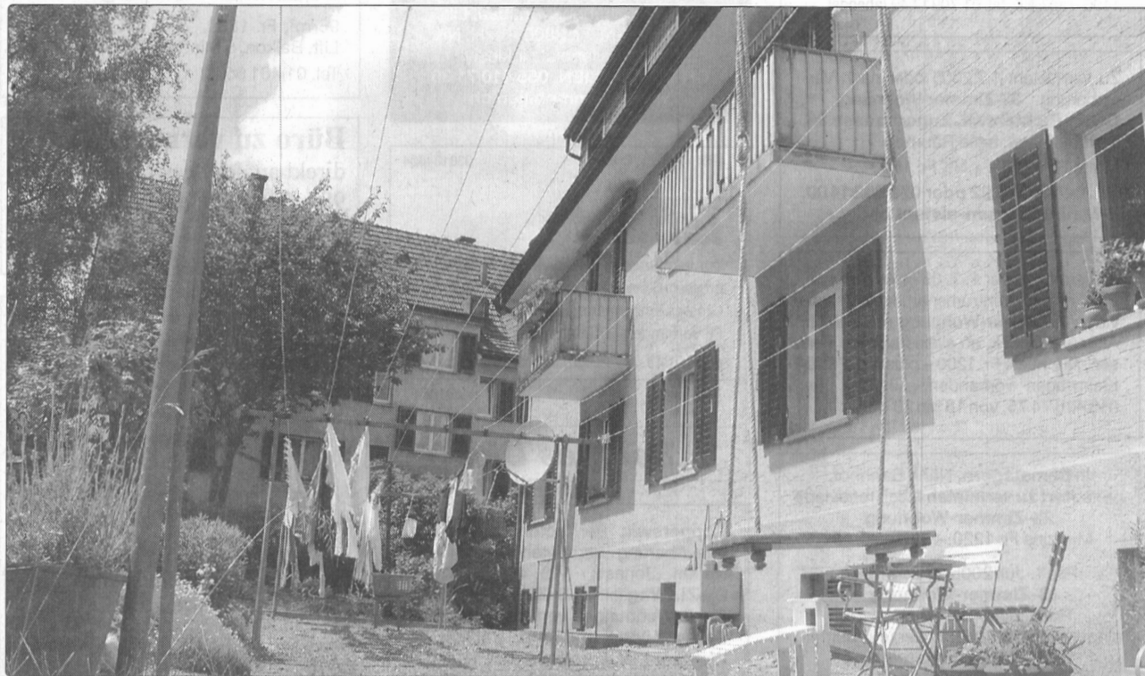
Die Gebäude zwischen der Thalwiler Rosen- und Bergstrasse, hier Bergstrasse 15, sollen einem Neubau weichen. Philipp Kutter
